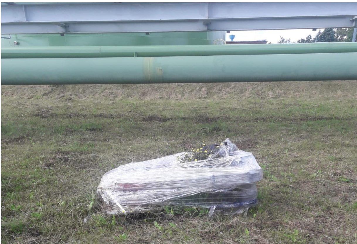
Przepustnica niewłaściwie przechowywana przez dłuższy okres czasu.
