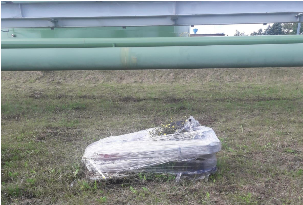
Niewłaściwie przechowywana przepustnica
