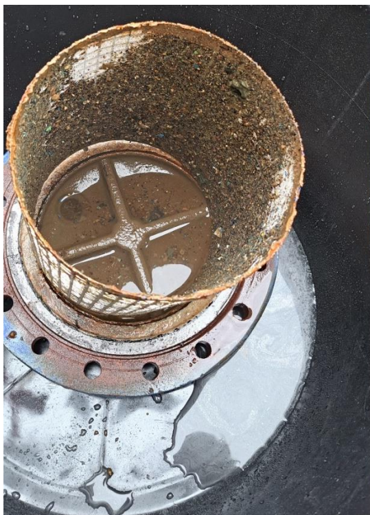
Sito filtra użytego do separacji cząstek stałych na instalacji
